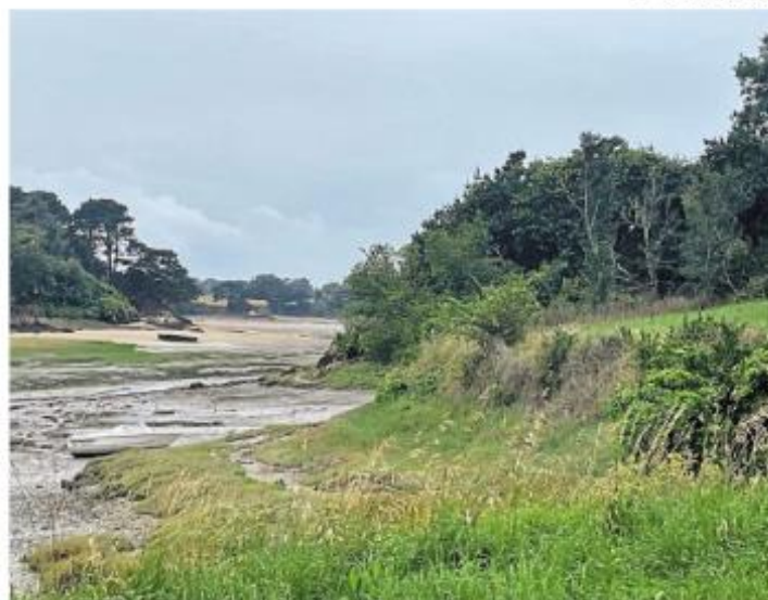
Le passage par la digue de l'ancien moulin à marée, en ruines, est submergé à marée haute, glissante de l'autre côté et dangereuse.
